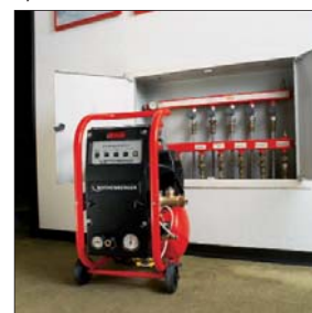
Промывка системы отопления пола
